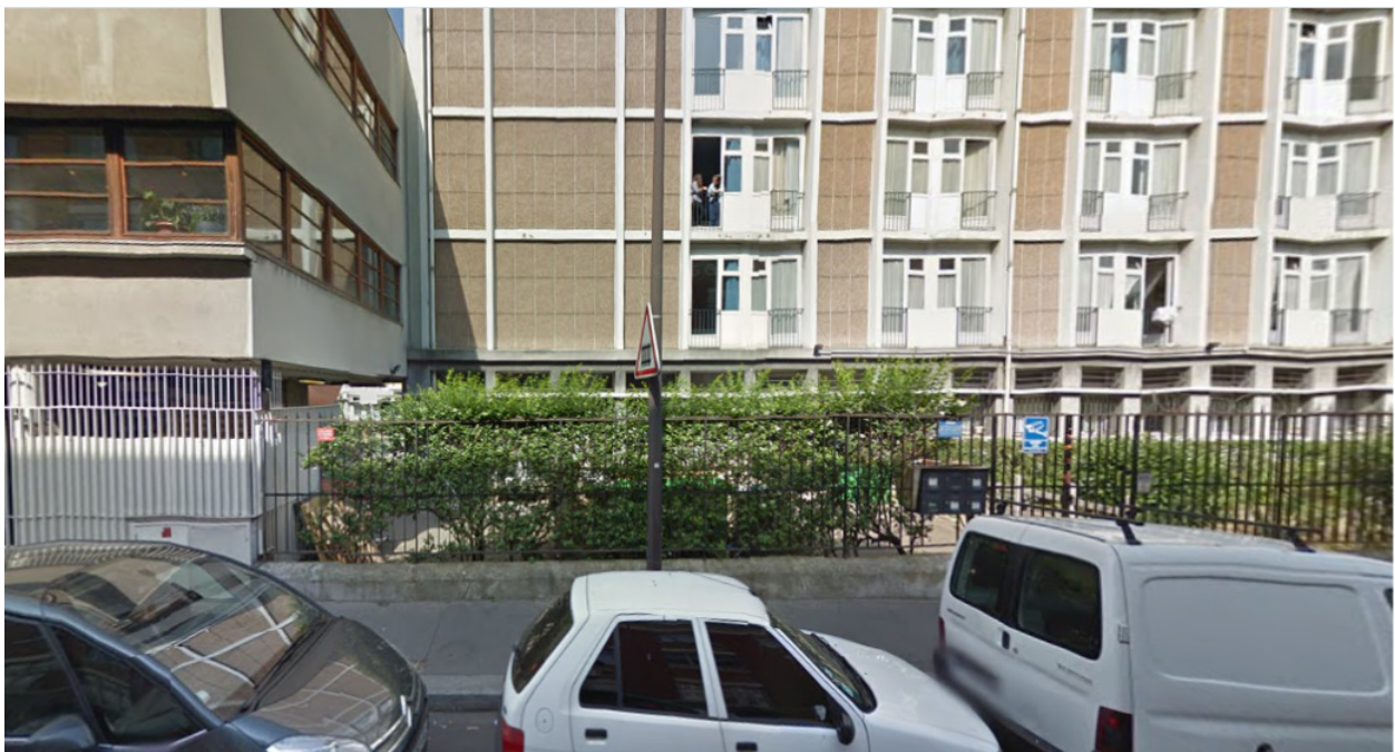
Rue du Général Niessel, Paris
